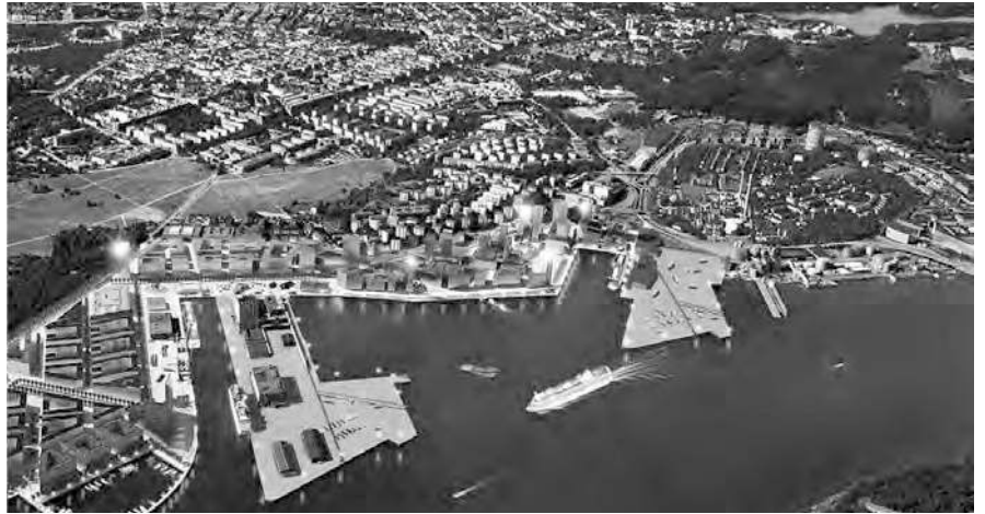
11 写真左が業務ゾーン・中央が大型客船の港で商業・観光ゾーン・右側の緑の多い部分が住環境であり、上部の奥には旧市街地が見られる。
